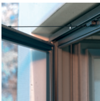
Ajtócsukó, állítható zárási sebességgel
